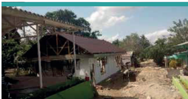
Proyecto Manos a la Obra: Mejoramiento de Escuela, Llano Grande- Tibú- ASOCATI III
